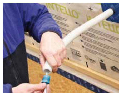
STOPPA dicht kabels in mantelbuizen af.
