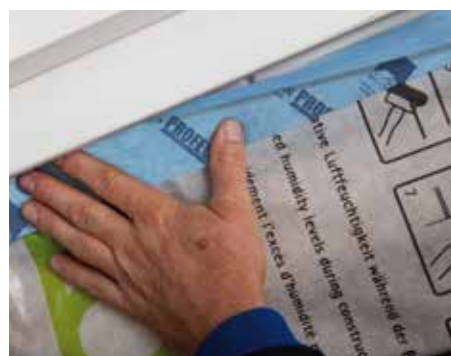
Aansluiting van inbouwelementen binnen,
