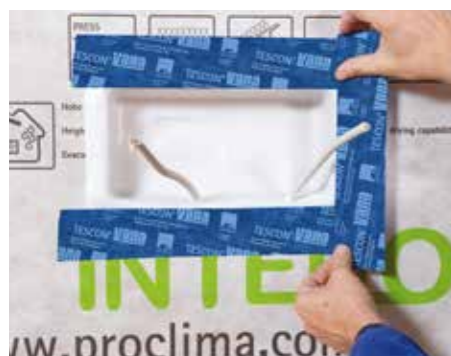
INSTAABOX creëert ruimte voor schakelaars en contactdozen.
