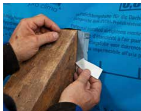
Verwijder de schutlaag en verkleef de folie luchtdicht op de spoor.
