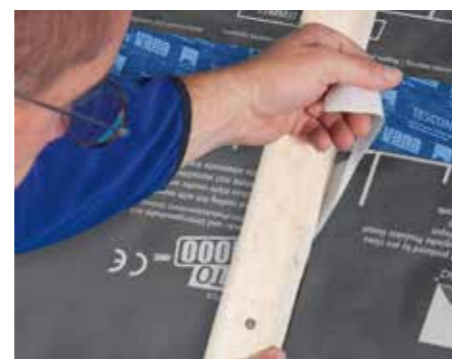
Verwijder stap voor stap de schutlaag.
