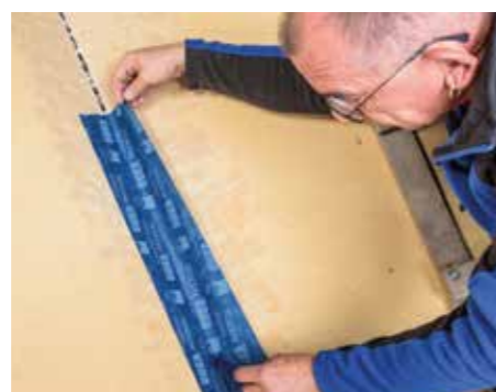
Tape kan direct in de primer worden verkleefd.
