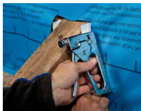
Niet de folie vast aan de hoeklijst.
