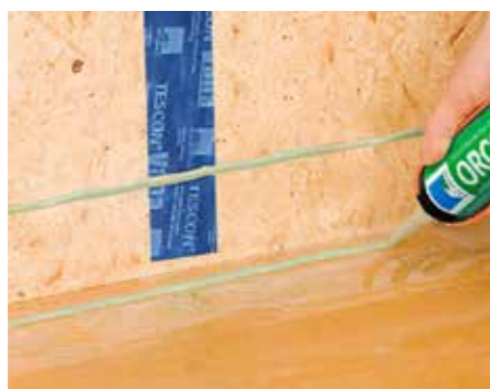
... en aansluitingen van houten platen op vloeren
