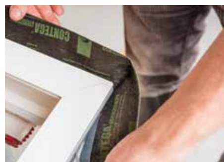
Bevestig de tape in de hoek (lengte: 1,5 x voegbreedte).
