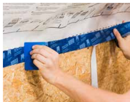
... aansluitingen op houten platen,
