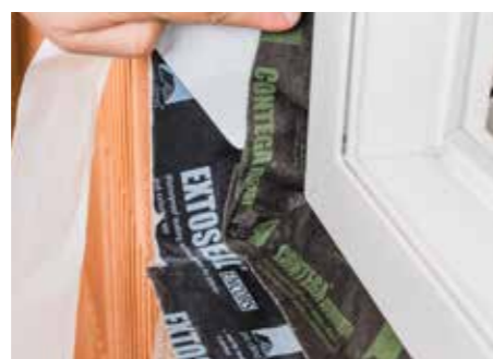
Verkleef het geheel in de hoeken lucht- en slagregendicht.
