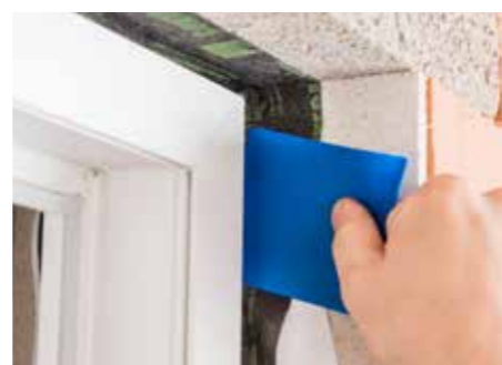
Wrijf de tape stevig aan met PRESSFIX.
