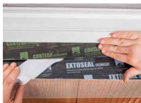
Plaats het raam, verwijder de schutlaag en verkleef de tape rondom in de dagkant.
