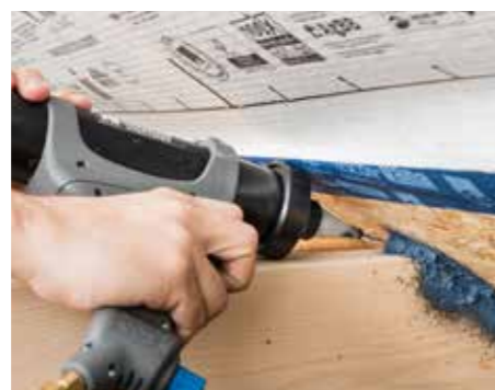
... moeilijk toegankelijke aansluitingen van balkkoppen,
