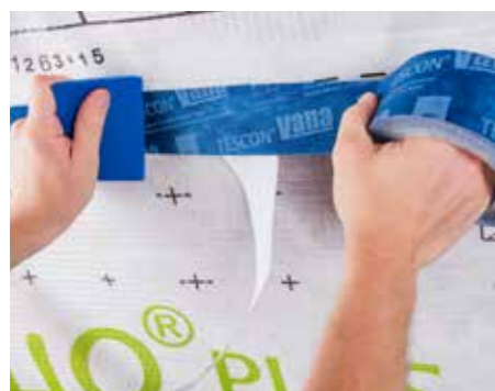
Verkleving van folieoverlappingsen binnen,
