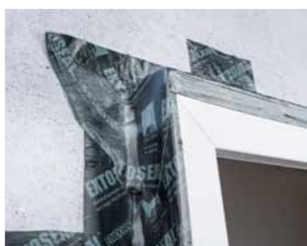
Aansluiting van ramen in metselwerk en beton.
