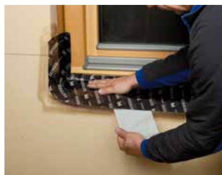
Toepassing als 2e waterkerende laag.
