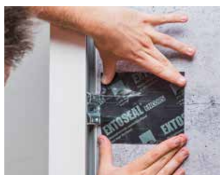
Waterafvoerende verkleving van bevestigingshoeken.
