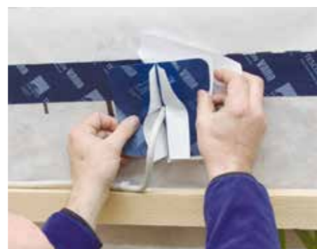
KAFLEX post, voor als het uiteinde van de kabel niet meer toegankelijk is.
