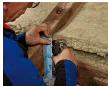
... en bevestig de hoeklijst aan de spoor.
