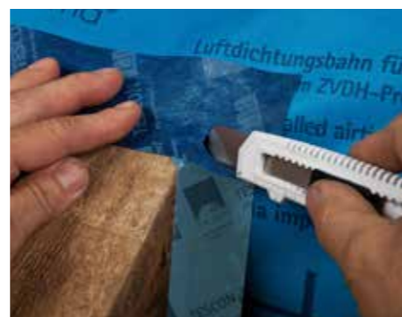
Sluit de folie met TESCOFIX VANA luchtdicht aan op de spoor.
