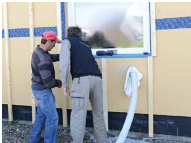
Iedereen levert een bijdrage: tijdens de workshop laat Holger Merkel van pro clima aan het team van Tasuleasa Social zien hoe je met een paar slimme aanpassingen een gebouw lucht- en winddicht kunt maken.
