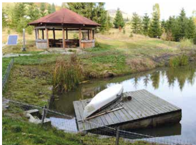
Duurzaam en zelfvoorzienend: de natuurlijke waterzuiveringsinstallatie op het terrein van Tasuleasa filtert en reinigt het afvalwater voordat het weer in de beek wordt afgevoerd.
