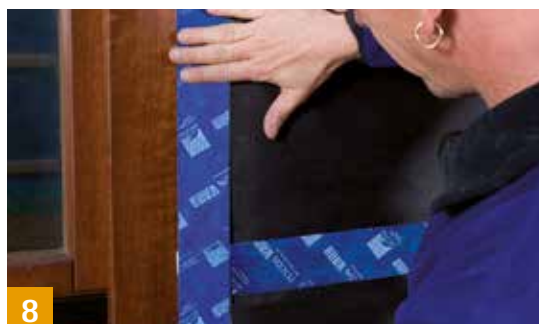
TESCON PROTECT Voorgeplooid hoekaansluitband
