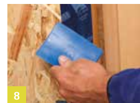
8 Dagkant rondom verlijmen met TESCON VANA
