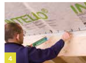
4 Aansluiting op hout
