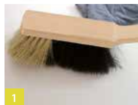
Ondergrond reinigen
