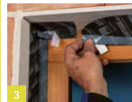
3 Raam rondom en over de hoeken verlijmen
