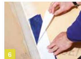
6 Houtvezelplaten gronderen
