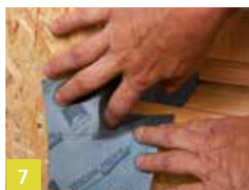
7 Verlijming in dagkant
