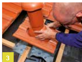
3 Ventilator met manchet opleggen
