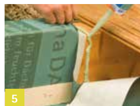
5 Aanbrengen van Sub-and-Top-baan
