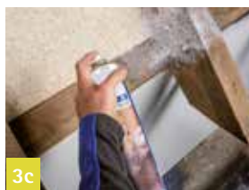
3c Primer aanbrengen
