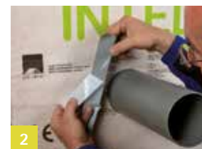
2 De eerste afdekfolie verwijderen
