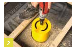
2 Onderdakbaan en isolatieplaat doorboren
