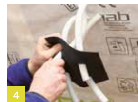
Legge buizen doorvoeren
