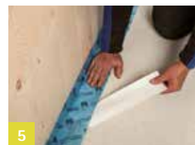
Aansluiting wand op bodemplaat/plafond
