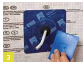
3 Manchet verlijmen en goed vastwrijven
