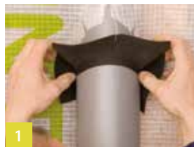
1 Manchet over de buis trekken en uitlijnen
