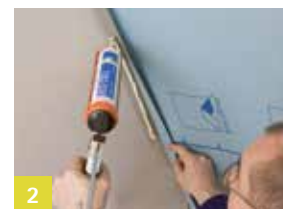
Aansluiting op gepleisterde gevelwand
