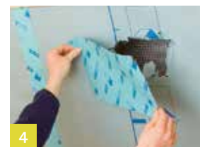
Detail reparatieverlijming
