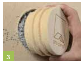
3 CLOX aanbrengen
