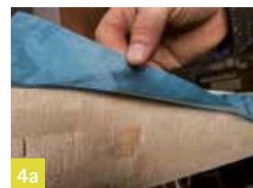
Verlijmen aan onderkant wand
