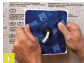
1 Kabel doortrekken en uitlijnen
