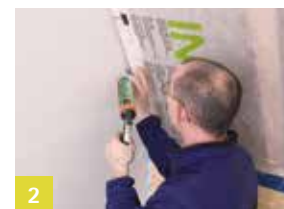
2 Aansluiting op gepleisterde gevelwand
