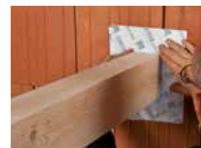
Hoekige doorvoer metselwerk / beton
