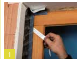
1 Op kozijn verlijmen
