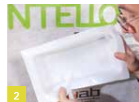
2 Doorvoer voorvormen
