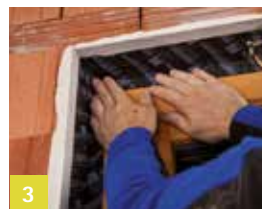
3 Over hoek vastplakken en rondom raam vastplakken
