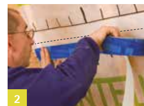
2 Baanoverlapping aanbrengen
