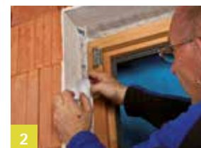
In de dagkant vastzetten en vastrijven
