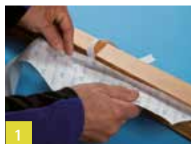
Aan de zijkant op het kozijn vastplakken
