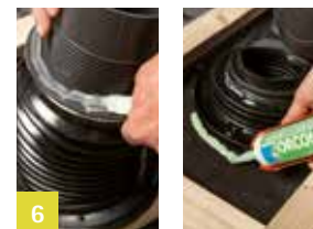
6 Aansluitlijm ORCON F of ORCON MULTIBOND opbrengen
