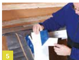
5 Aansluiting vlakdakraam
