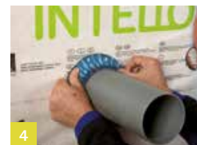
4 Op het vlak verlijmen
