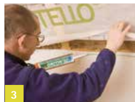
3 Aansluiting op gepleisterde borstwering
