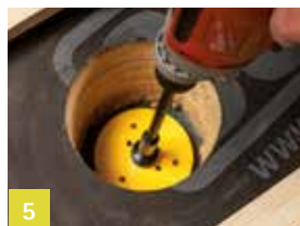
5 Damprem en beplanking doorboren
