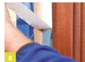
8 Gevelvenster – tweede flank verlijmen
