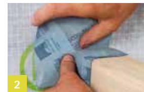
2 Verlijming op doorvoer
