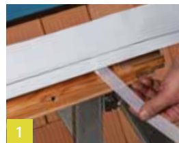
1 Aan de zijkant op het kozijn verlijmen
