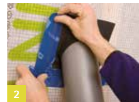
2 Manchet verlijmen en goed vastwrijven
