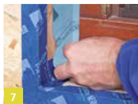
7 Gevelvenster – eerste flank verlijmen
