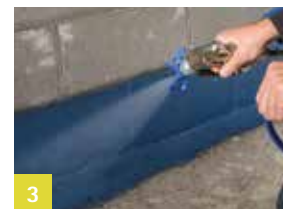
3 Spuitfolie aanbrengen (Airless-spuitmethode)
