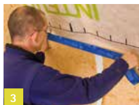
3 Aansluitingen op gladde, niet-minerale ondergronden
