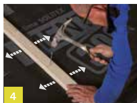
Tengellat positioneren en bevestigen
