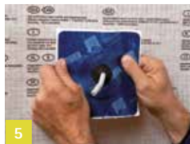
5 Aansluiting op kabels en buizen
