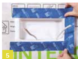
5 Lucht dicht aansluiten met TESCO VANA
