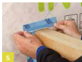
5 Aansluiting met kort kleefbeen
