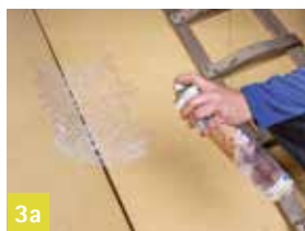
1 Ondergrond reinigen
