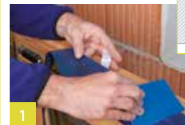
1 Band op het kozijn vastkleven
