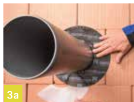
3a Met de ondergrond verlijmen
