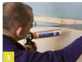
Aansluiting op gepleisterde borstwering
