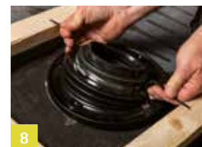
8 Op de onderdakbaan aansluiten
