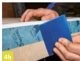
Verlijmen aan onderkant wand
