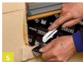
5 Horizontaal uitstekend band afsnijden
