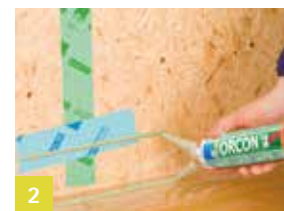
2 Aansluiting vloerplaat
