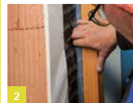
2 Met uitzettingsvouw op dagkant verlijmen
