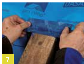
7 Vastplakken op bovenkant spant
