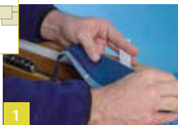
1 Band op het kozijn vastkleven
