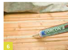
6 Aanbrengen luchtdichting buiten
