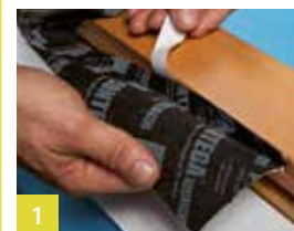
1 Aan de zijkant op het kozijn vastplakken
