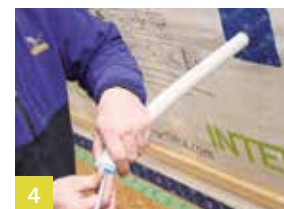
4 Luchtdicht verbinden met mantelbuis
