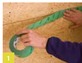
1 Voorbereiden / Verlijming plaatvoegen
