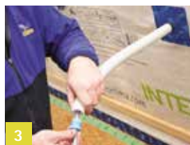
3 Kabel doorvoeren
