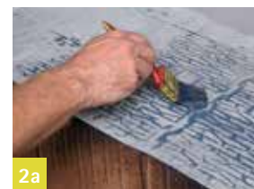
2a Gebreken in de ondergrond wegwerken
