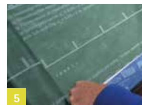
5 Aansluiting verlijmen
