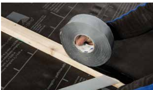
TESCON NAIDECK mono als nageldichting tussen de tengellatten...
